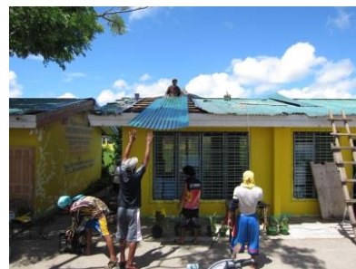
■大工たちは、1日も早く修繕を完了させるため学校に泊まり込んで作業しています(2014年4月25日、パロ町)
