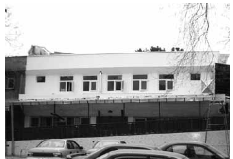
カブールの理学療法学校にスロープ（手前の柵の部分）が増設された（2011 年 1 月）
