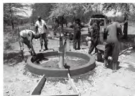
地域の井戸修理技術者とともに井戸を修理している様子（2015年10月）
