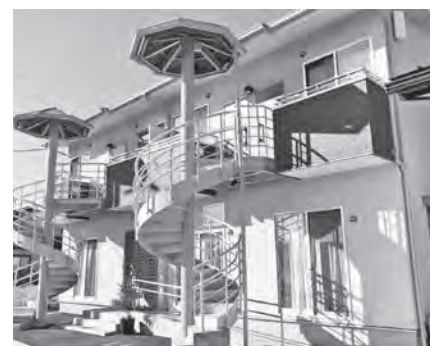
真備町の障がい者が暮らすグループホームを再建した (2019年11月、岡山県倉敷市真備町)
