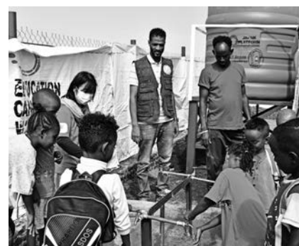
難民居住地の小学校に手洗い場を設置（2021年10月）
