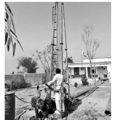
トイレや手洗用の水源を確保するため、山間部にある女子小学校にて井戸を掘削（2022年2月）
