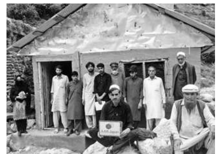
再建した発電小屋(2025年7月)
