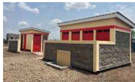
AARがナシヨノカ校の女子寮に建設し たシャワー棟（手前）とトイレ棟（奥）
