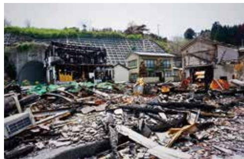
火災のため焼失した家々＝大船渡市三陸町で 2025年4月19日
